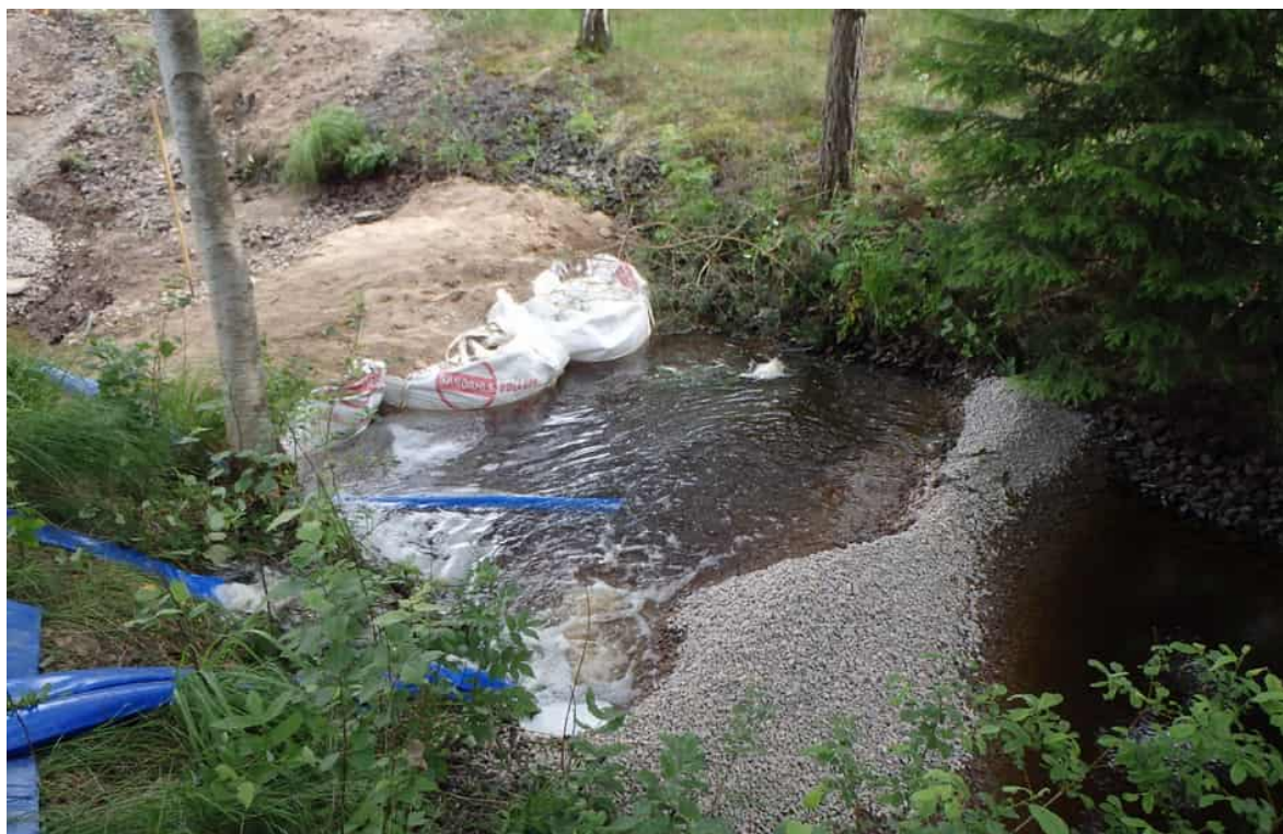
Figur 21. Exempel på skyddsåtgärd med en genomsläpplig barriär. tillfälligt dämme i vattendrag. Vatten pumpas förbi arbetsområdet. (Källa foto: Trafikverket, Agne Gunnarsson).
