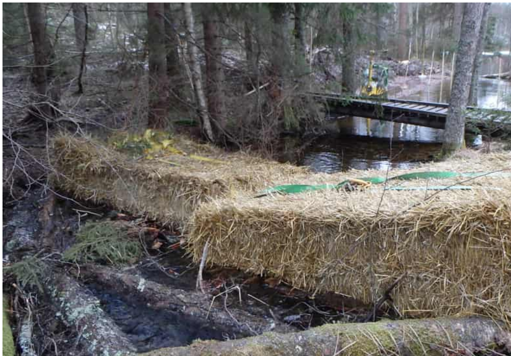
Figur 23. Exempel där halmbalar lagts ut för att dämma vattenflödet och samla upp sediment vid arbetet i vattenområden (Källa foto: Trafikverket (Agne Gunnarsson)).
