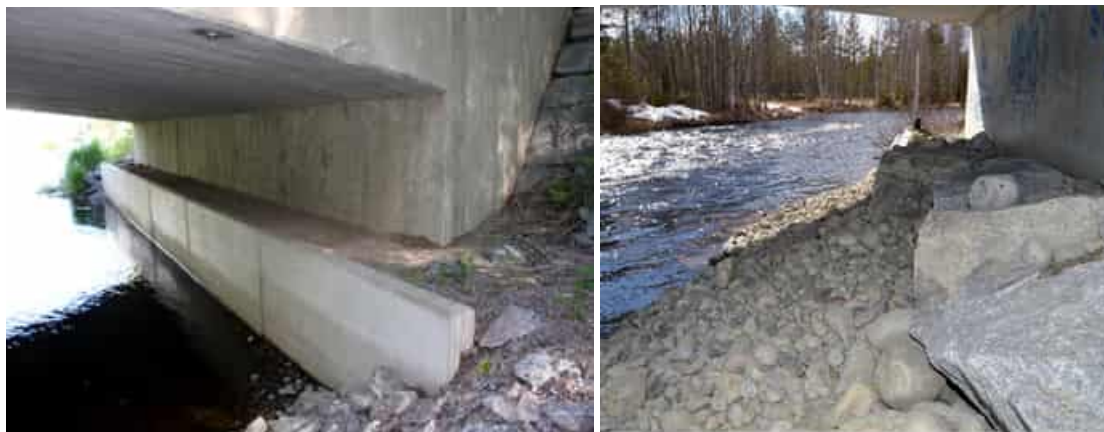
Figur 16. Strandpassage med betongstöd (vänster) respektive stenblock (höger). Bild hämtad från Temablad Natur "Faunapassager för utter och medelstora däggdjur".
