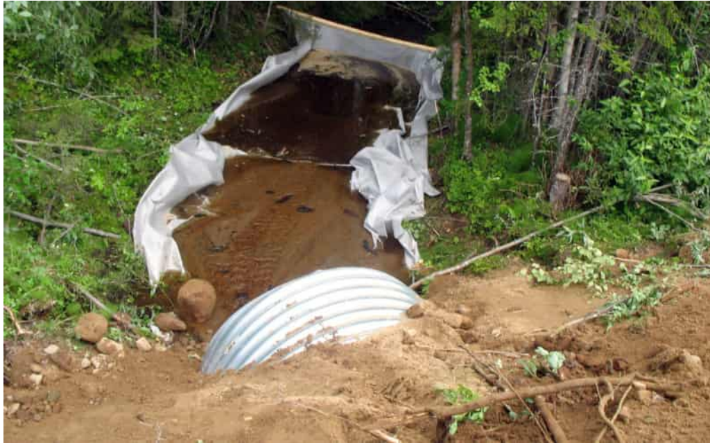
Figur 22. Exempel där geotextil lagts ut för att samla upp sediment vid anläggande av trumma (Källa foto: Trafikverket 2014).
