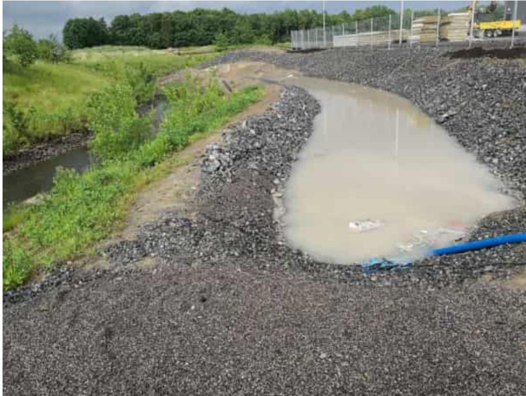
Figur 24. Exempel på möjlig tillfällig damm (källa: Swedish Hydro Solutions, 2021).
