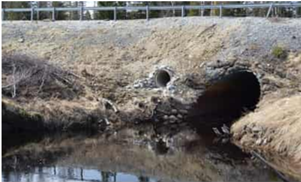
Figur 17. Torrtrumma vid vattendrag. Bild hämtad från Temablad Natur "Faunapassager för utter och medelstora däggdjur".
