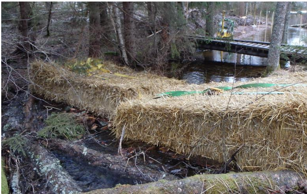
Figur 35. Exempel där halmbalar lagts ut för att dämpa vattenflödet och samla upp sediment vid arbetet i vattenområden (källa foto: Trafikverket, Agne Gunnarsson).
