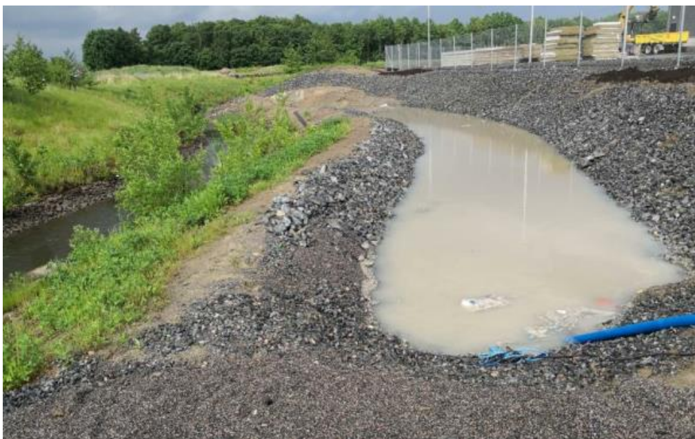
Figur 36. Exempel på tillfällig damm (källa: Swedish hydro solutions. 2021).
