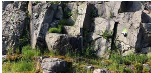
Figur 31. Referensbild bultning. Vid risk för bergutfall kan bergbult användas som förstärkningsinsats.
