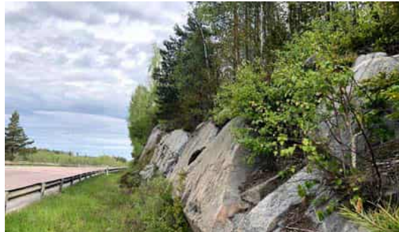
Figur 30. Befintlig bergsskärning längs väg 583.
