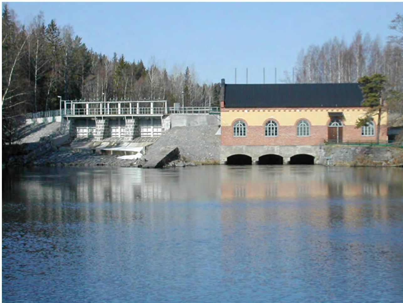
Kraftverket Pappers väster om Iggesund
