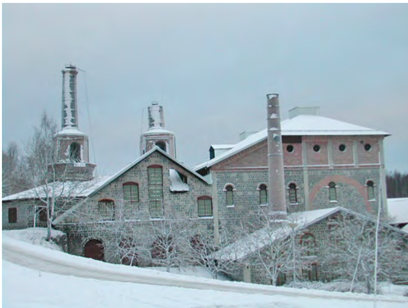
Järnverket i Iggesund
