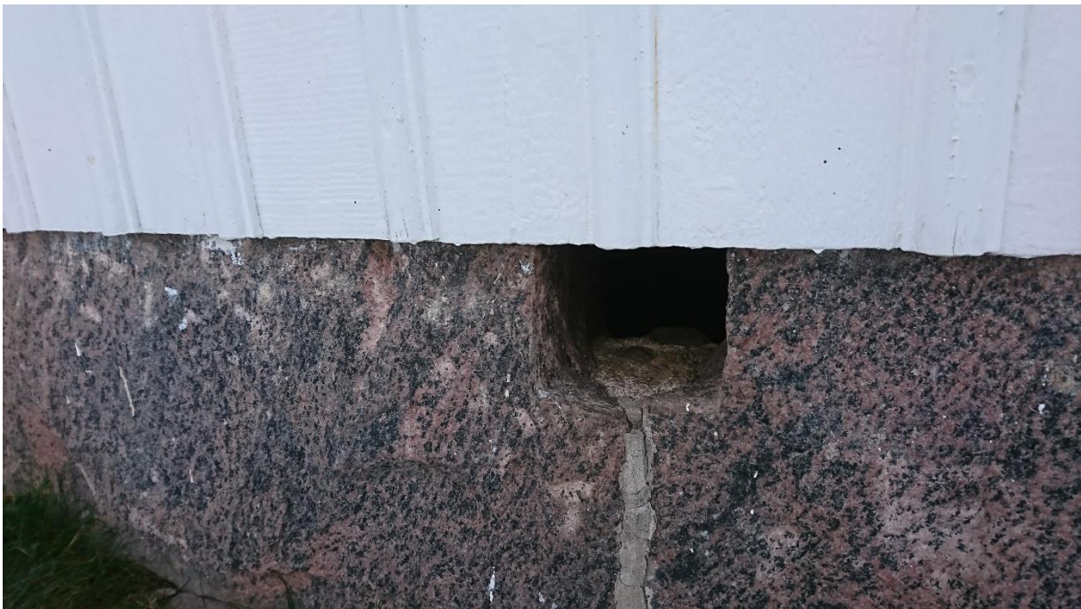
Figur 4: Norra fasaden mot järnvägen – "kattglugg" in till källaren.
