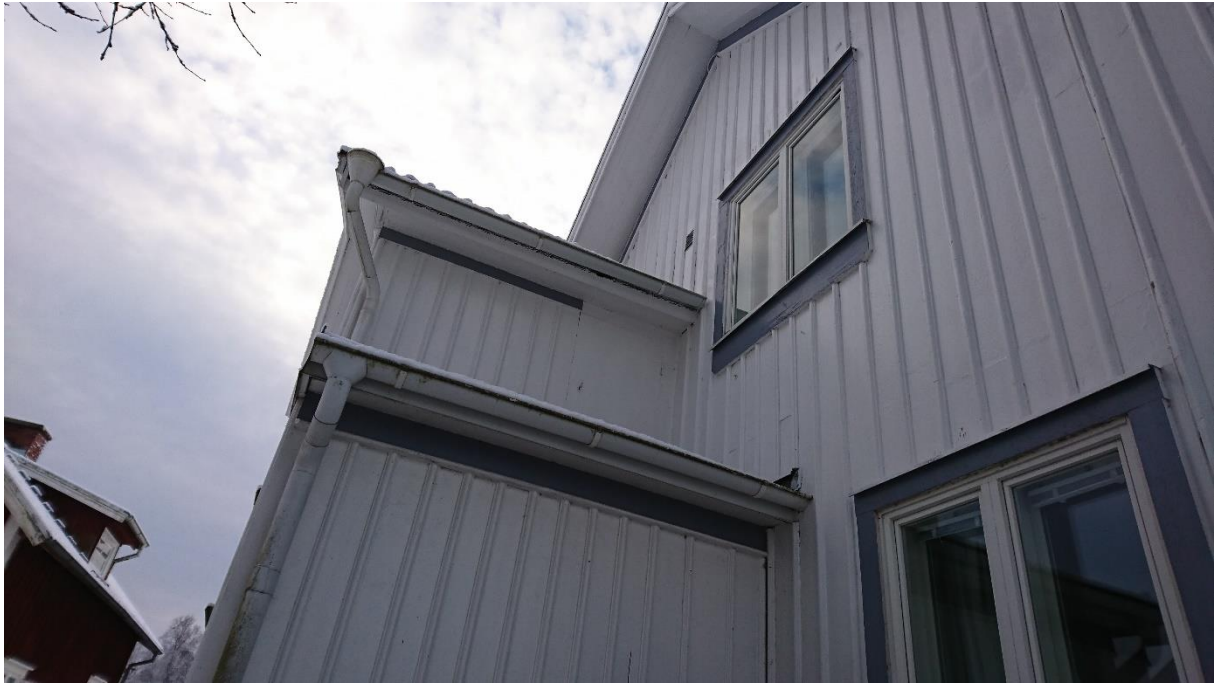
Figur 5: Östra fasaden med ventil in till bostadsrum på andra våningen.
