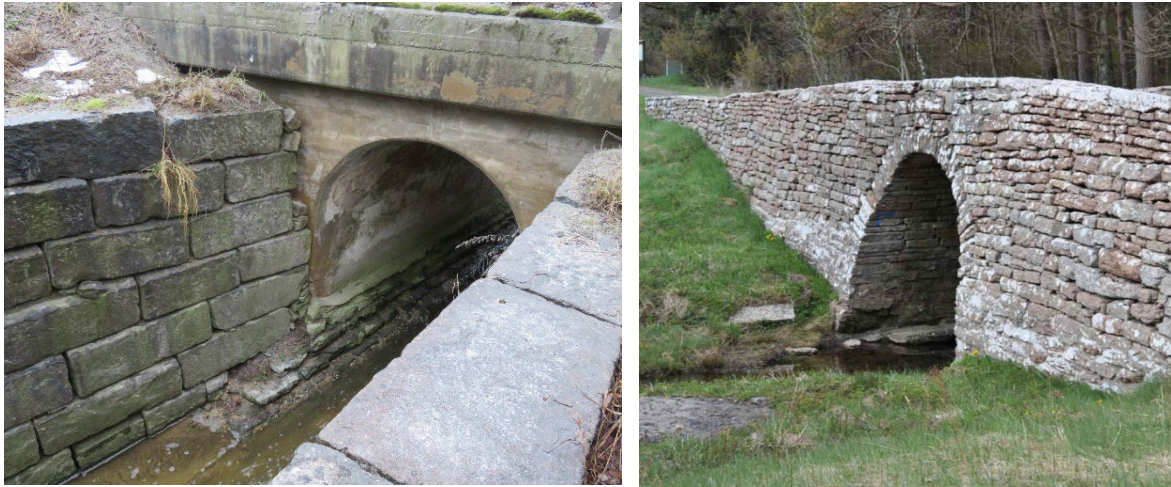
Figur 20. Foto från väster. Här syns skoningen huggna granitblock som finns på båda sidorna av bron, bronns valv av betong från 1900-talets första hälft samt brofundament i kalksten av okänd ålder. Fotot till höger visar en kalkstensbro i Norra Kvinneby på Öland för jämförelse med fundamenten.
