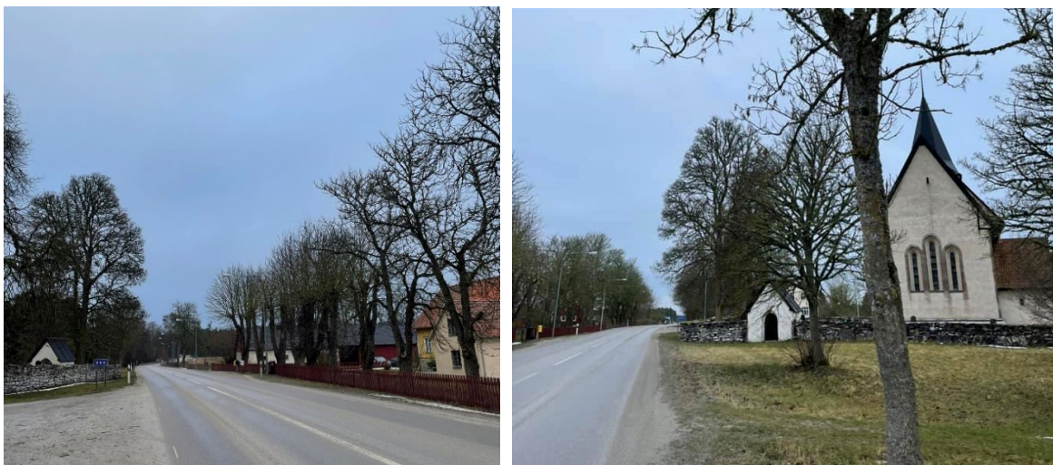
Figur 25. Den kulturhistoriskt värdefulla miljön som kan påverkas genom intrång i miljöerna på båda sidor om vägen samt om den hårdgjorda ytan blir mer framträdande i miljön. Bild till höger visar kyrkogårdsmurens närhet till Väg 148.
