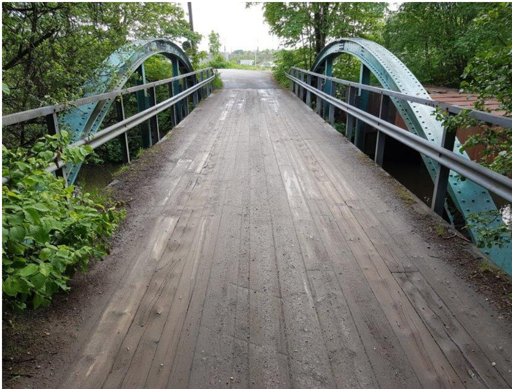
Figur 24. Befintlig bro vid Lärjeån, riktning söderut.
