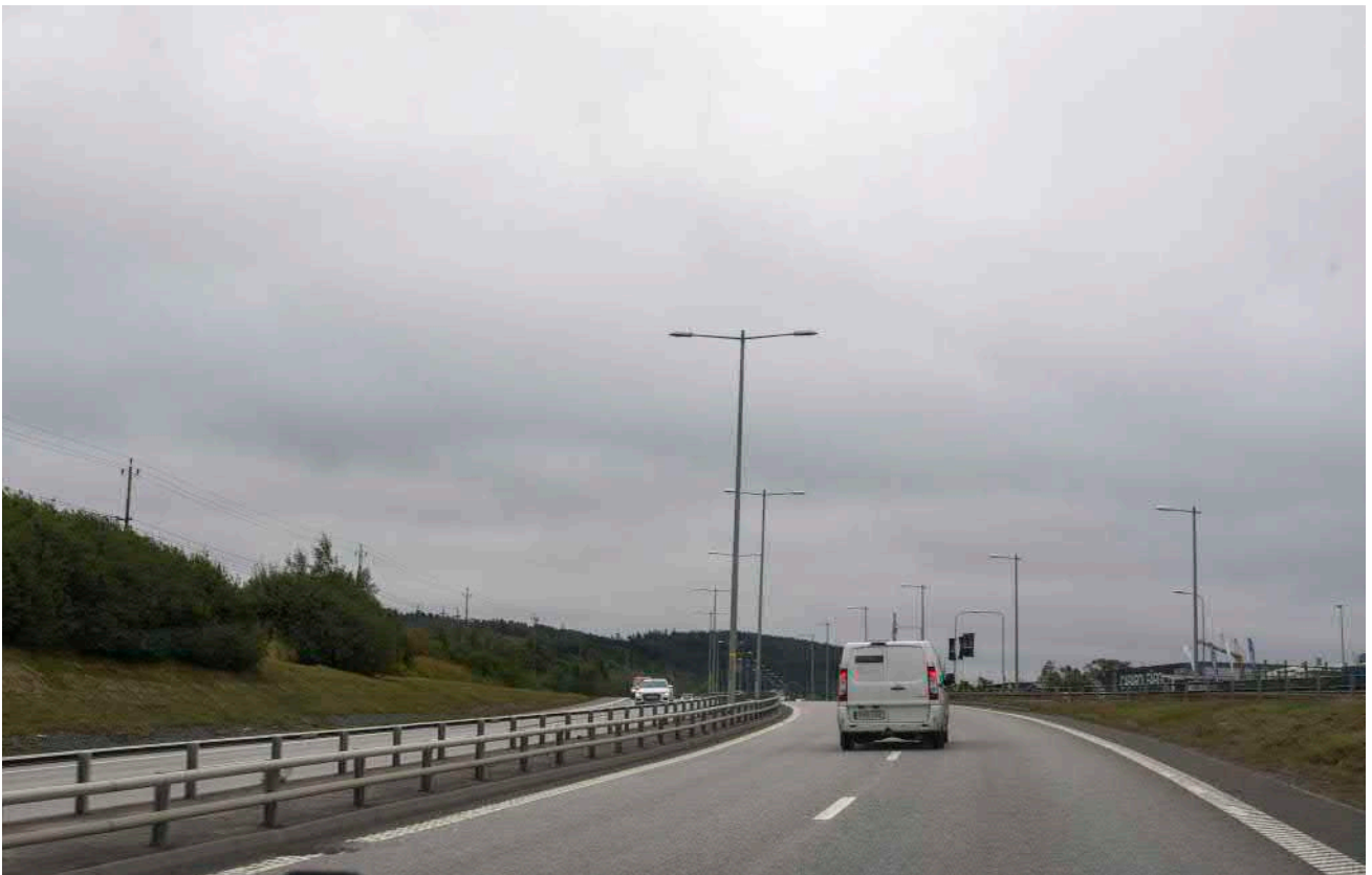
Figur 24. Väg E45 och Norge-/Vänerbanan utgör kraftiga barriärer i området. Utredningsområdet är till vänster i bild.
