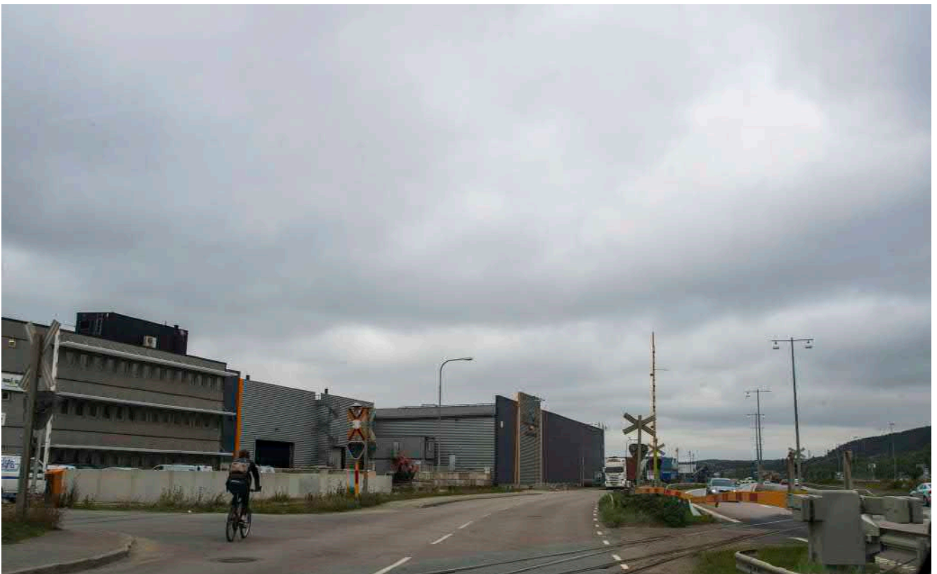
Figur 5. Stora lagerbyggnader i verksamhetsområdet Alelyckan västra. Sett från Marieholmogatan mot norr med plankorsning och E45 till höger i bild.
