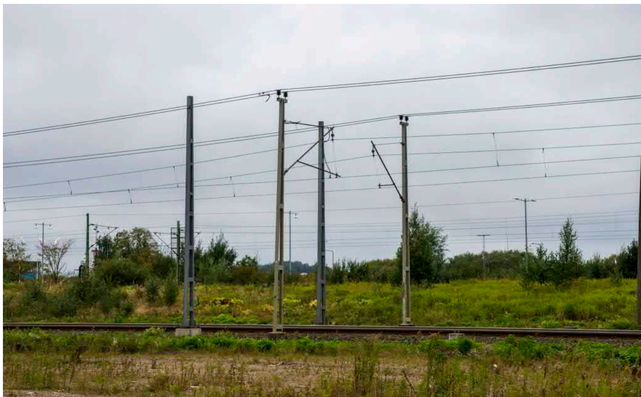
Figur 16. I den södra delen av uppställningsområdet möts spårväg, järnväg och E45. Belysningsstolparna över vägen syns i bakgrunden.
