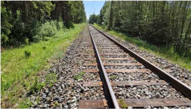
Bild 7. Rabbalshede, provomgång 1, före besprutning.
