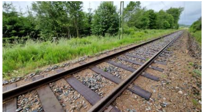
Bild 8. Rabbalshede, provomgång 2, före besprutning.
