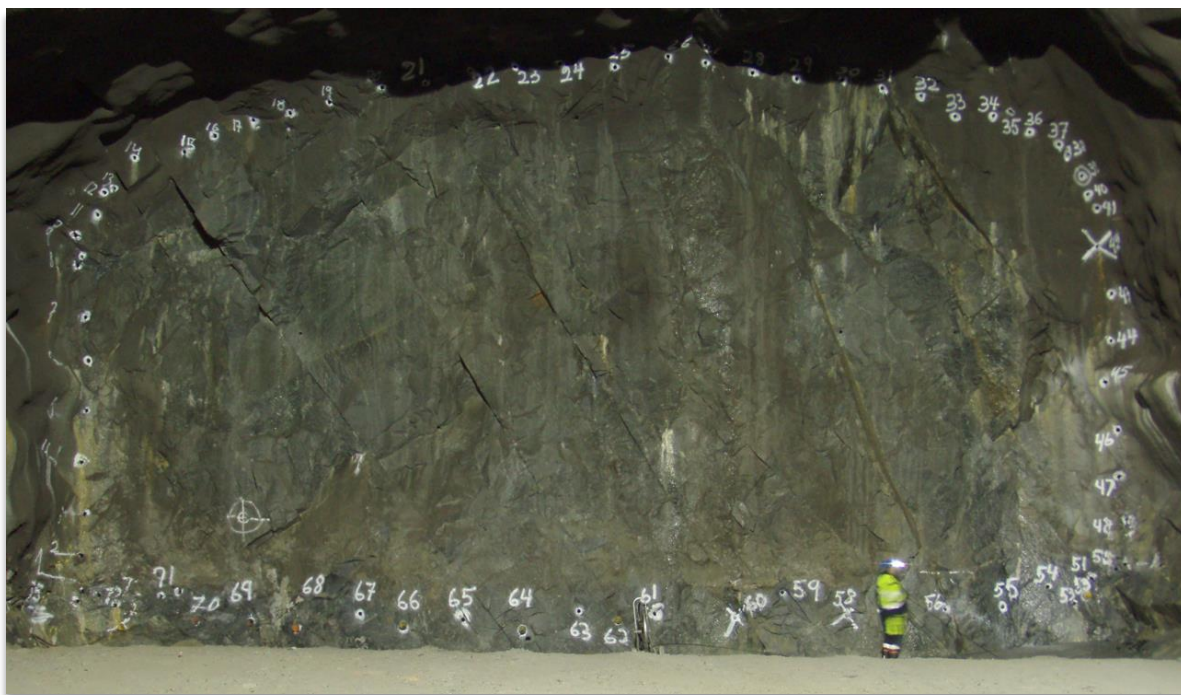
Figur 3-7. Ansättning av injekteringshål i en storblockig bergmassa.
