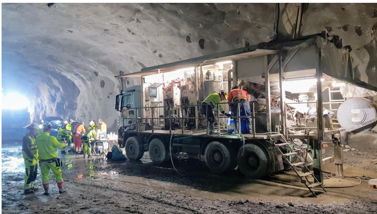
Figur 4-1. Injekteringsutrustning och förprovning av injekteringsbruk vid Akalla (FSE613).
