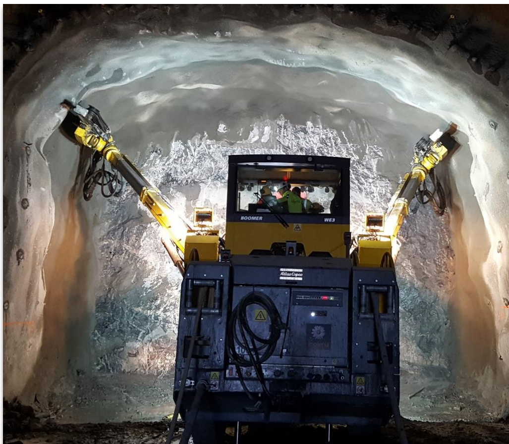
Figur 3-6. Borrrigg uppställd för att påbörja borrning av injekteringshål.
