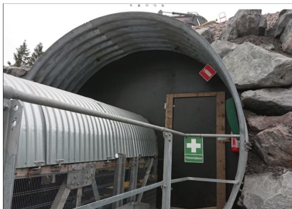
Figur 8. Inbyggnad av tunnelmatarens öppning mot transportband.
