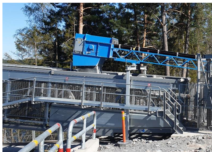
Figur 5. Foto på utbytt stup 3 Norra Lovö.
