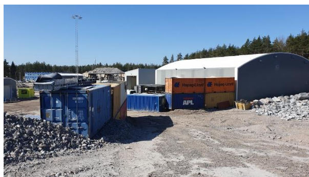
Figur 10. Placering av bullerskyddsskärmar i form av containrar staplade på varandra för att minska krossens buller mot fastigheterna Maltesholm 1 och Hogsta 4:15.
