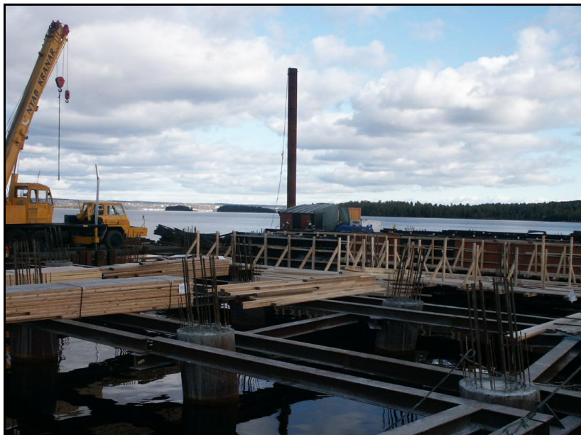
Foto 8.4 Formsättning, underform på tillfälligt balksystem fäst i pålarna (Foto: Gregor Rolski, Sweco)
