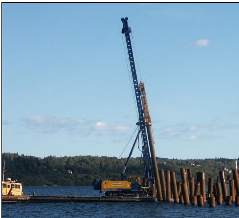
Foto 8.2 Slagning från ponton av stålrörspålar för en kaj (Foto: Gregor Rolski, Sweco)
