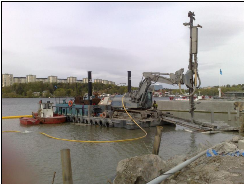
Foto 8.1 Borrning från ponton av stålrörspålar för en kaj (Foto: Per Vallander, Sweco)
