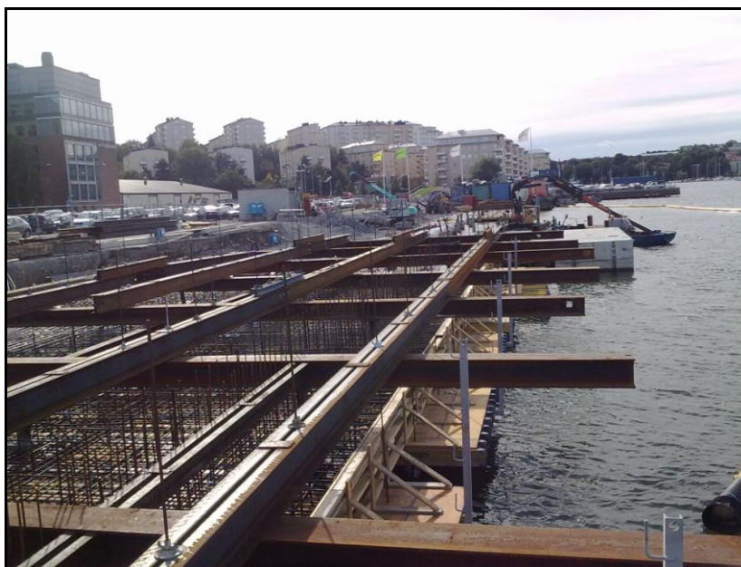
Foto 8.5 Armering av påldäck, hängform (Foto: Alrik Lundin, Sweco)
