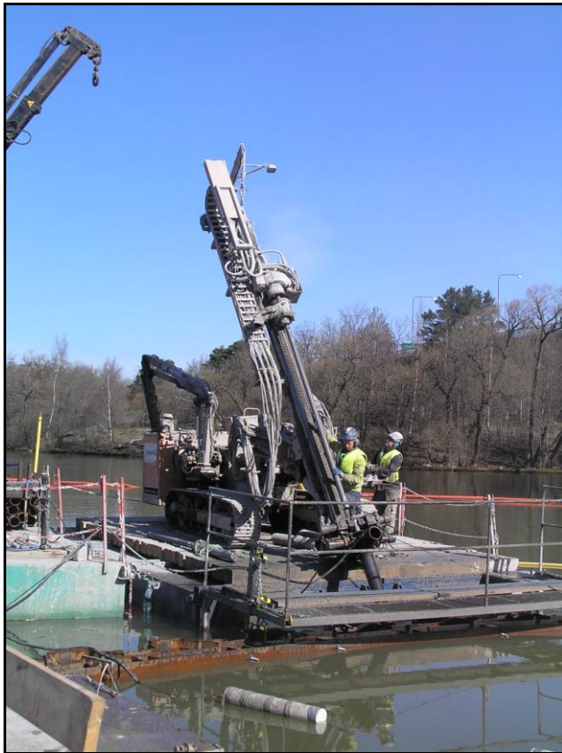
Foto 8.3 Borrrigg på ponton (Foto: Sweco)
