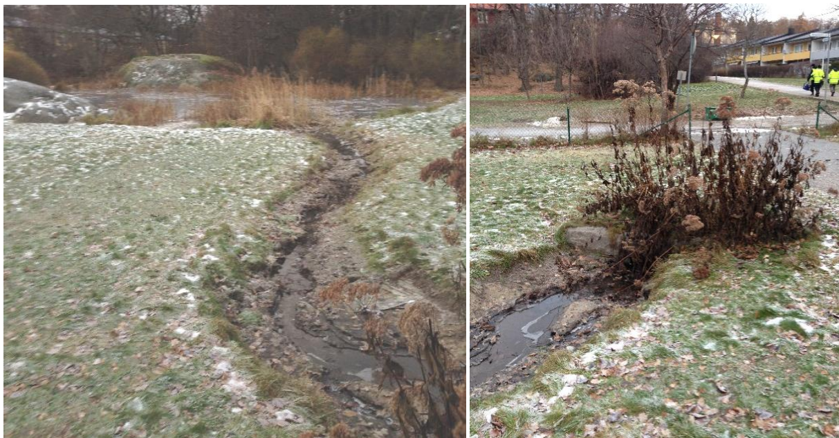
Figur 20: Befintlig kanal från utlopp söder om Sätträgdsvägen ner till dammen vid Sätträåns början.
