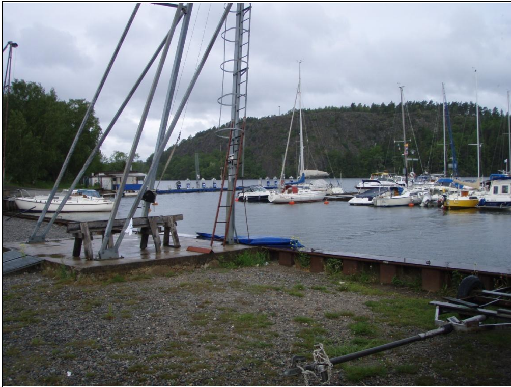
Figur 6-2. Befintlig slip och mastkran. Mot väster syns den befintliga båtmark som planeras att rivas för att ge plats åt RoRo-rampen.
