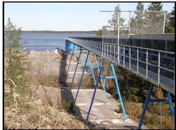
Figur 10-5. Exempel på bandtransportör på mark respektive på pelarstöd. Transportören på mark har en undergång för viltpassage. (Foto Kjell Windelhed, Trafikverket)
