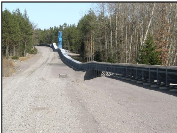
Figur 10-5. Exempel på bandtransportör på mark respektive på pelarstöd. Transportören på mark har en undergång för viltpassage. (Foto Kjell Windelhed, Trafikverket)
