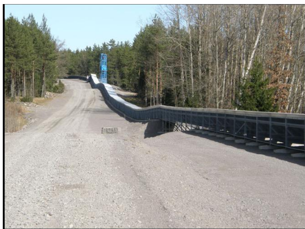
Figur 10-2. Exempel på bandtransportör på mark respektive på pelarstöd. Transportören på mark har en undergång för viltpassage. (Foto Kjell Windelhed, Trafikverket)
