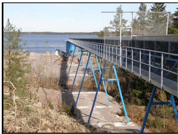
Figur 10-2. Exempel på bandtransportör på mark respektive på pelarstöd. Transportören på mark har en undergång för viltpassage. (Foto Kjell Windelhed, Trafikverket)
