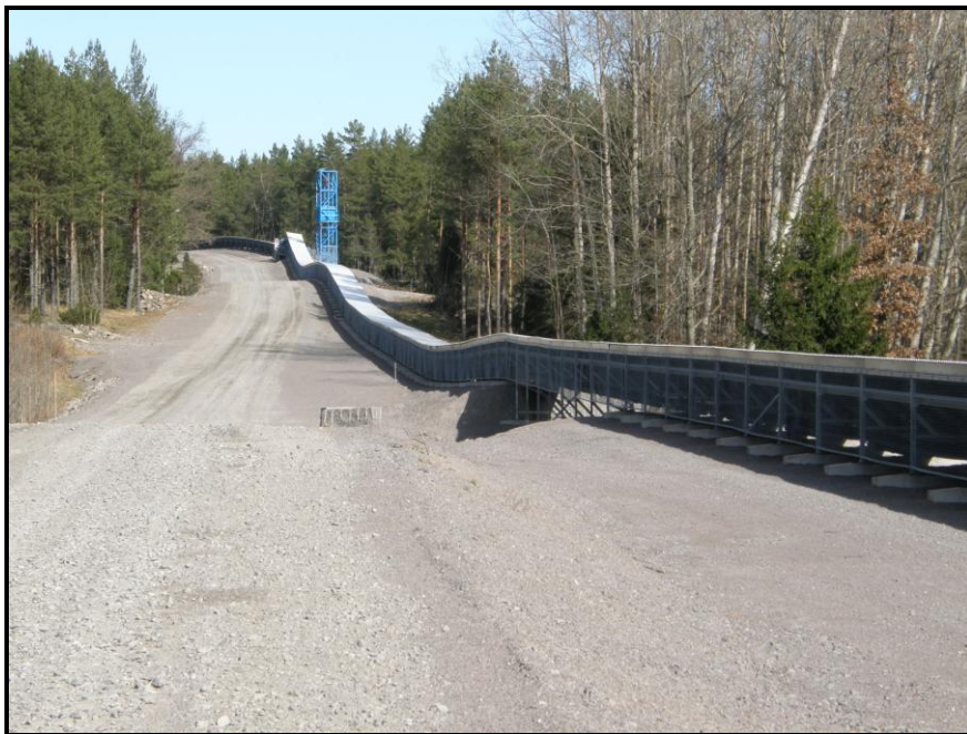
Foto 5.2 Exempel på bandtransportör på mark och med undergång för vilt passage. Vägen på fotot byggdes ursprungligen för dubbelriktad trafik med dumprar, vägen till den nu aktuella tillfälliga hamnen kan göras smalare. I bakgrunden syns ett motviktstorn för reglering av bandspänningen. (Foto: Kjell Windelhed, Trafikverket)
