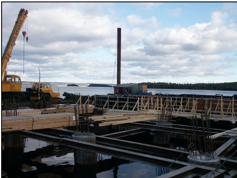
Foto 7.4 Formsättning, underform på tillfälligt balksystem fäst i pålarna (Foto: Gregor Rolski, Sweco)
