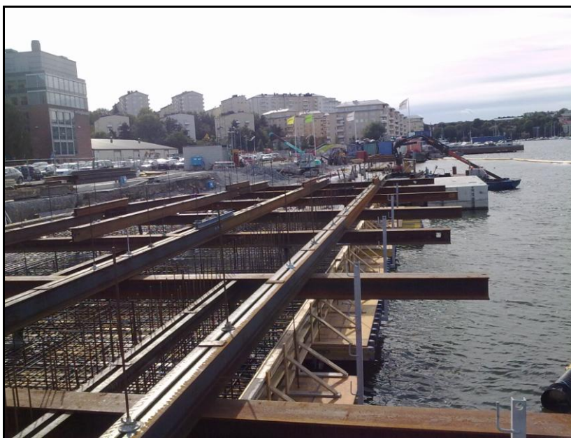
Foto 7.5 Armering av påldäck, hängform (Foto: Alrik Lundin, Sweco)
