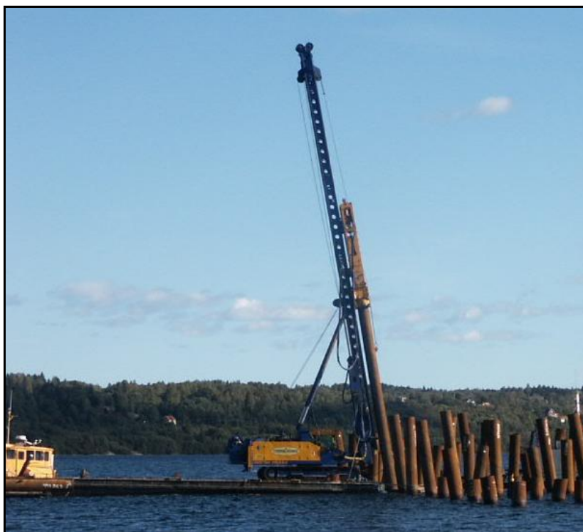
Foto 7.2 Slagning från ponton av stålörspålar för en kaj (Foto: Gregor Rolski, Sweco)
