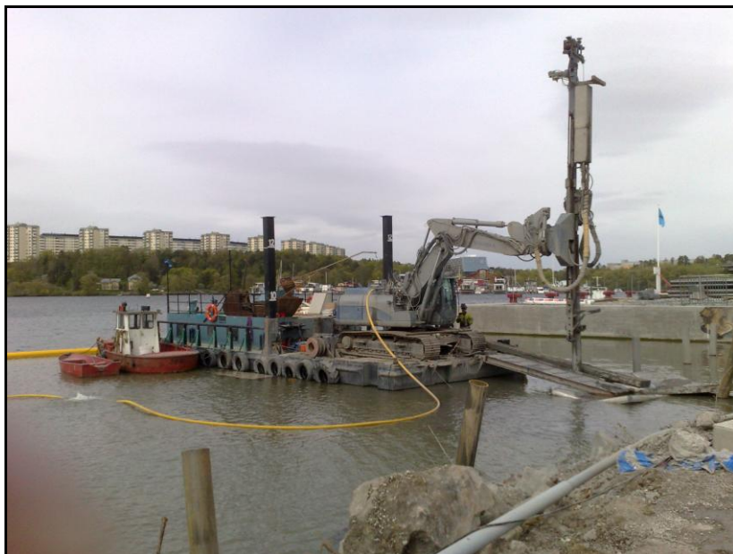
Foto 7.1 Borrning från ponton av stålörspålar för en kaj (Foto: Per Vallander, Sweco)
