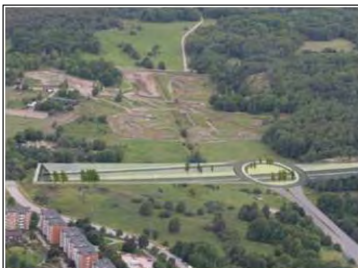
Figur 3-13. Bildmontage av Akalla trafikplats med anslutande betongtråg från söder och Hägerstalunds motorbana i bakgrunden. Vy från sydost.
