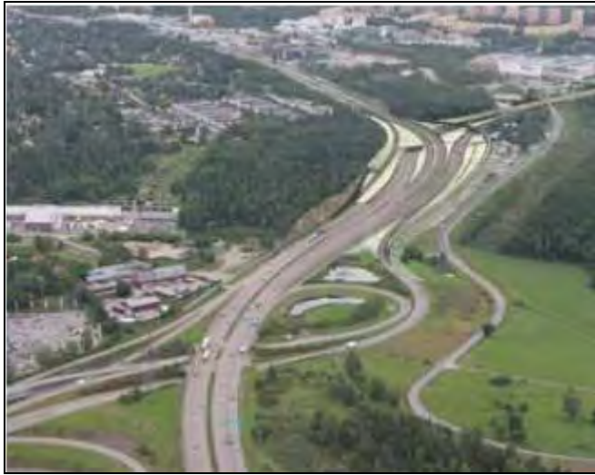
Figur 3-14. Bildmontage av Häggvik trafikplats. Vy från norr.
