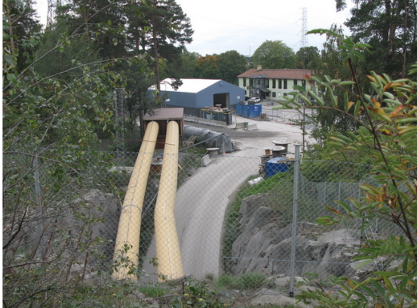
Figur 8 visar arbetstunneln för kraftledningstunneln mellan Skanstull – Solberga, tidigare arbetstunnel för Södra Länken. I anslutning till arbetstunnel finns en etablering med plats för verkstadstält, förråd, kontor samt ett mindre mellanupplag för berg.
