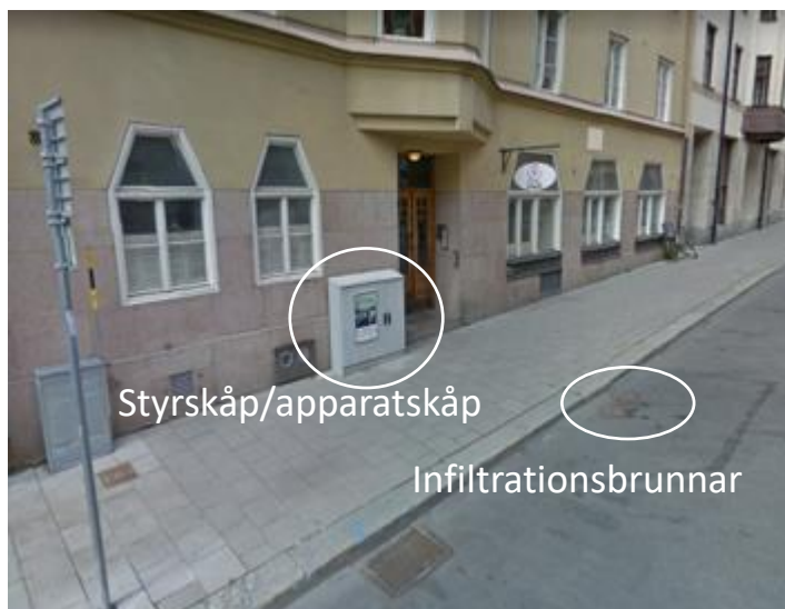
Figur 14. Exempel på infiltrationsanläggning i stadsmiljö.
