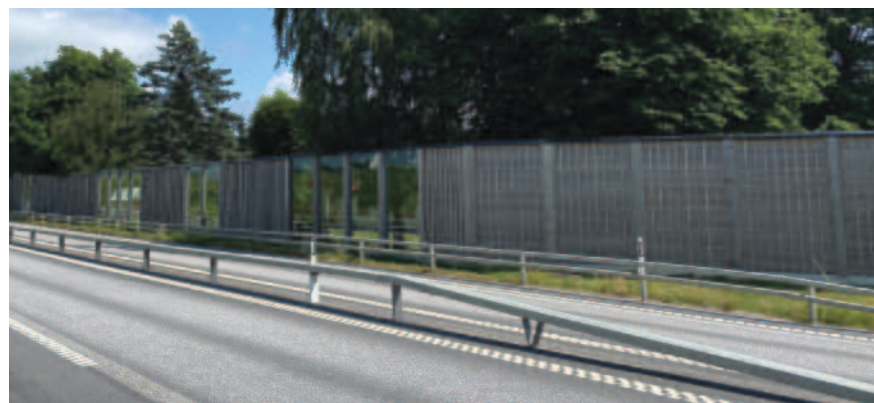
Figur 15. Bullerskärm. Här visas en naturgrå variant med stående lister i fyllningen och i kombination med genomsiktliga partier. Exempel från väg 19, norr om Ystad.
