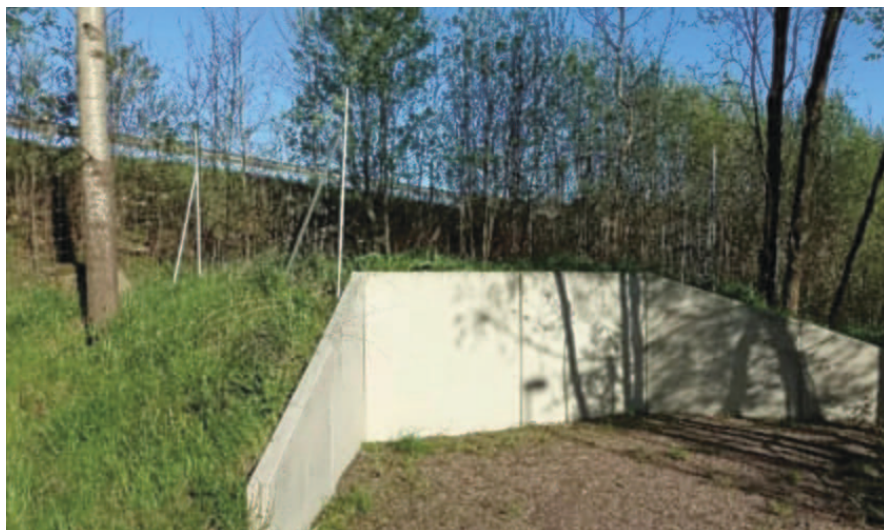
Figur 10. Exempel på viltuthopp i släntfot, uppbyggd av L-stöd i betong. Observera hur viltstängslet ansluter till uthoppet ovanpå stödkonstruktionen. Foto: Mats Lindqvist, TRV.
