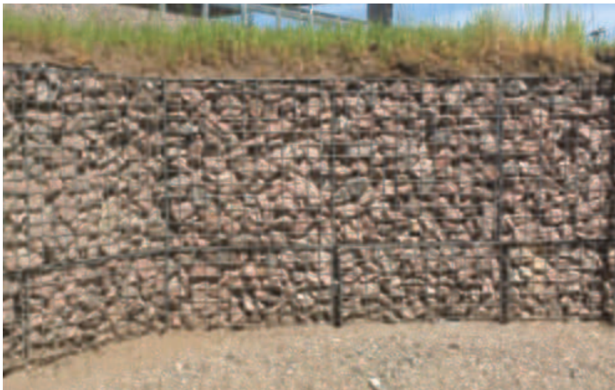
Figur 14. Exempel på viltuthopp uppbyggd av gabioner och med sand på landningsytan. Observera den tjocka och täta grästorven ovanpå gabionen som hindrar djur från att trampa ner i stenfyllningen. (E20 etapp Vårgårda – Bälinge)
