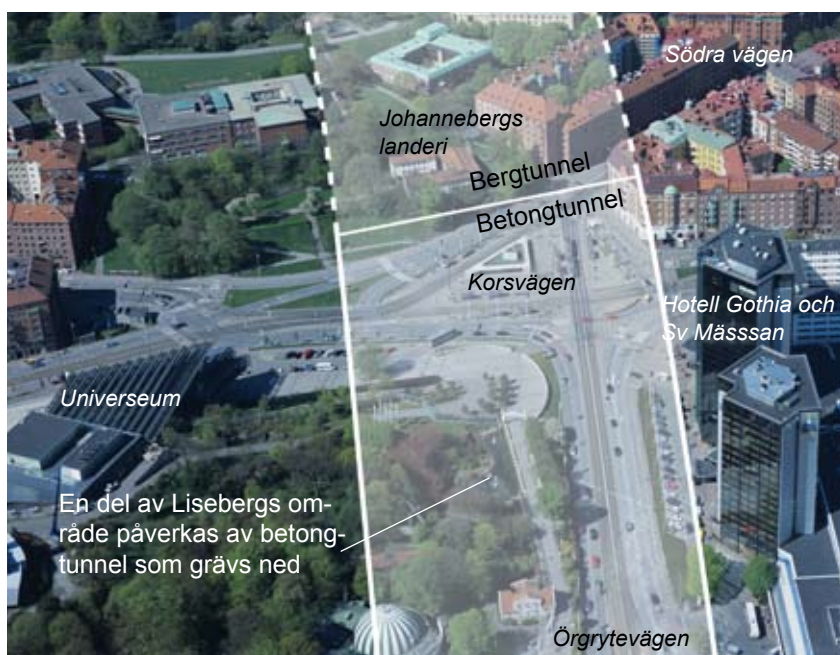
Korsvägen / Liseberg. Grävarbeten kommer att påverka trädbeståndet i Lisebergs nordvästra hörn. Denna dragning ingår i alternativet Haga-Korsvägen.
