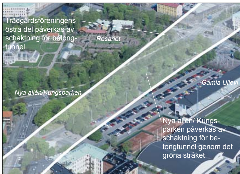
Trädgårsföreningen / Kungsparkens östra del. Grävarbeten kommer att påverka huvuddelen av det uppvuxna trädbeståndet i Kungsparkens östra del. Denna sträckning ingår i alternativ Korsvägen.
