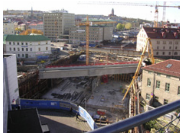
Figur 4 Övergång mellan betong- och bergtunnel vid Götatunnelns södra del.
