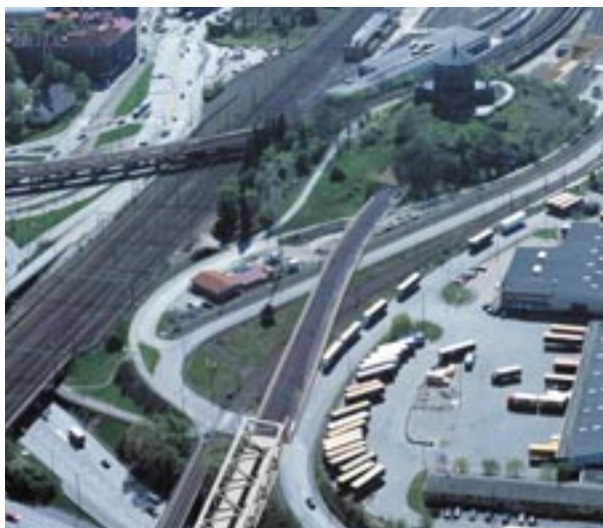
3. Tråg och tunnel under Skansen Lejonet.
