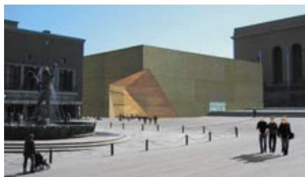
Station Korsvägen. Uppgång Götaplatsen
