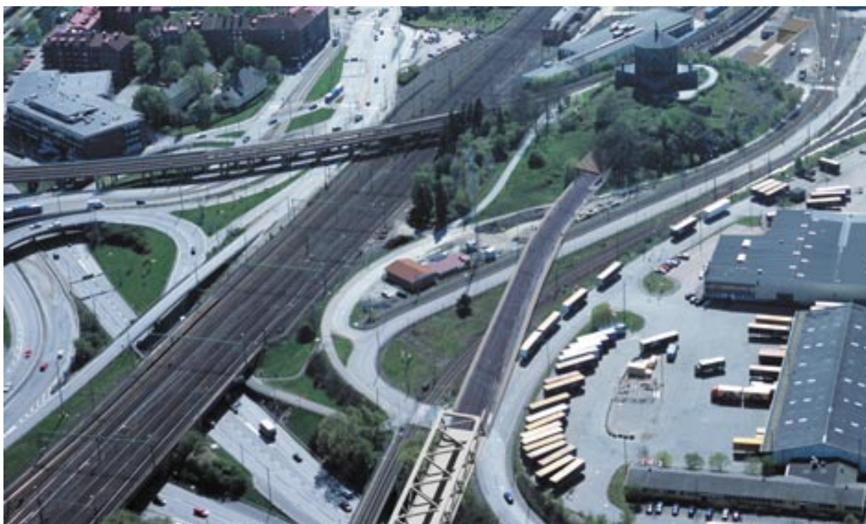
Tråg och tunnel under Skansen Lejonet.
