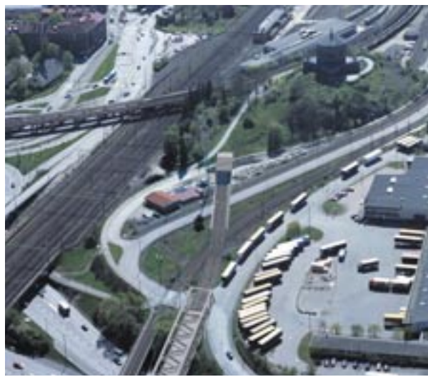
4. Tråg och tunnel vid Skansen Lejonet.
