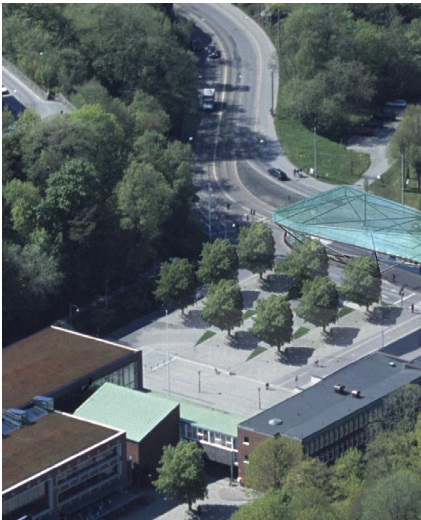
Station Chalmers, södra uppgång vid Chalmers. Flygfoto från sydost.
