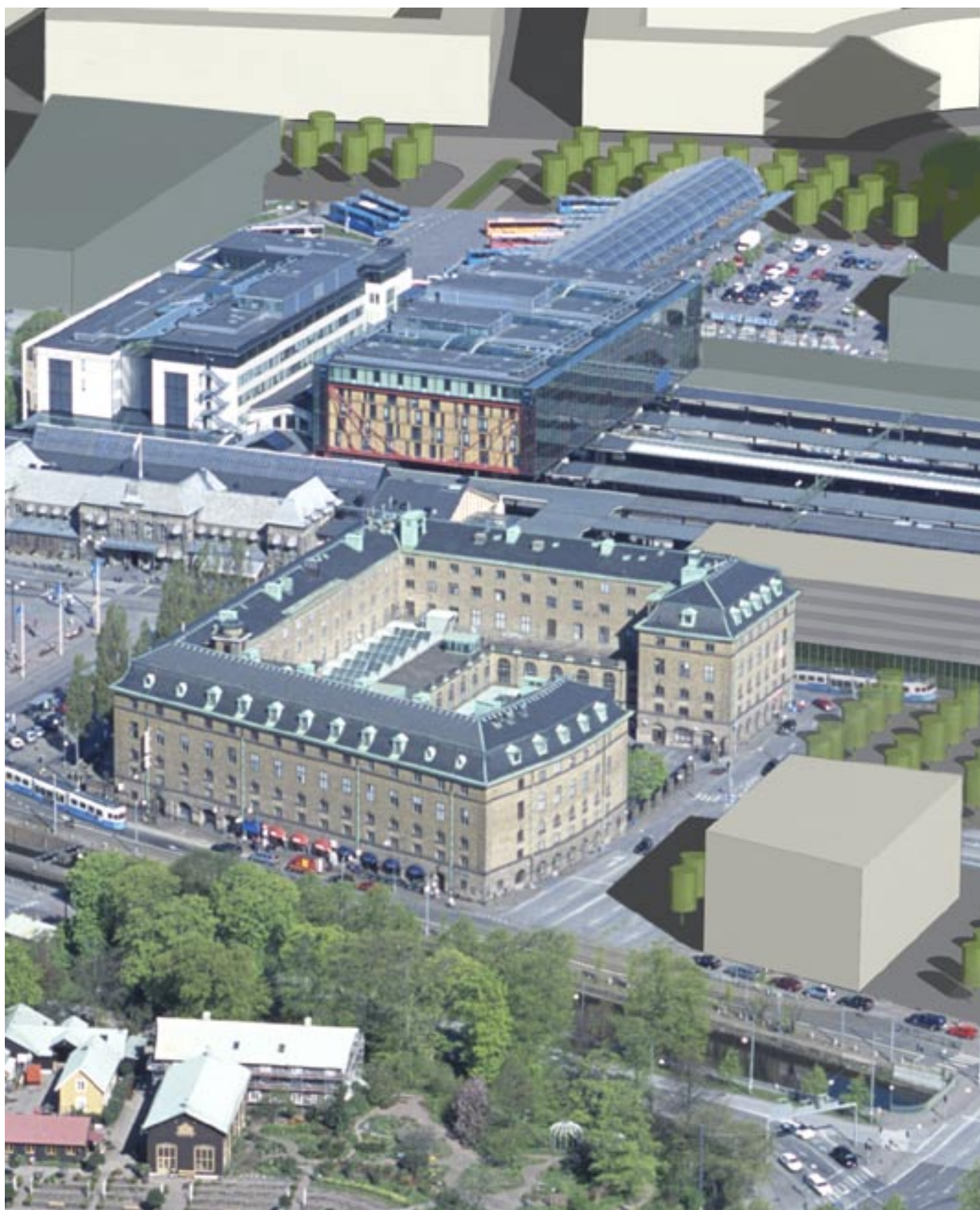
Station Göteborg Central, huvuduppgång på Akareplatsen.
