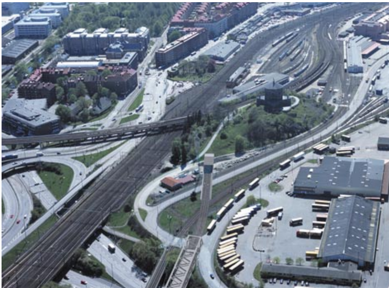
Tråg och tunnel vid Skansen Lejonet.
