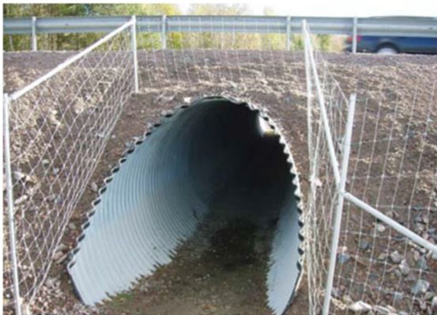
Figur 22 - Stängselutformning vid rörbro och trumma (Ill.2.4:3 ur VV publ. 2006:47).
