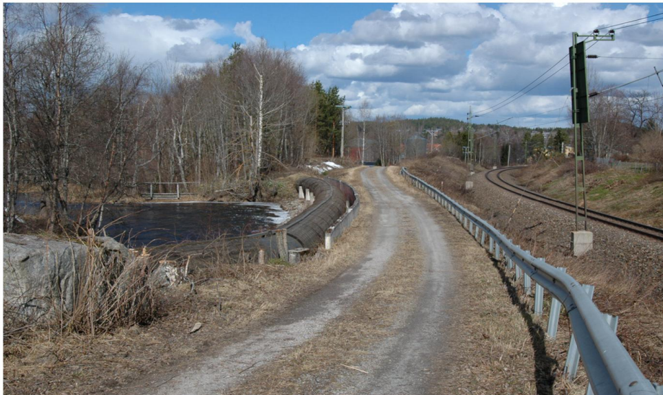
Figur 8.2-7. Damm i Stångån till vänster, ca 100 meter nedströms Stångholmsbron. Befintlig järnväg till höger om Turistvägen. Delar av Turistvägen följer den från början av 1800-talet använda kyrkvägen från Skedlo. Källa och foto: Stigfinnaren.
