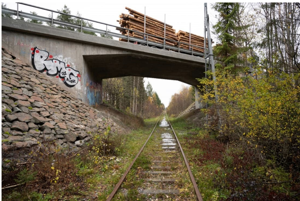
Figur 4.5 – Bro 21-205-1 är en vägbro över järnvägen Dellenbanan.
