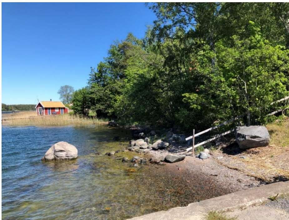
Figur 11. Båtupptagningsrampen för fritidsbåtar norr om reservfärjeläget, Blidö. Sett från väster.
