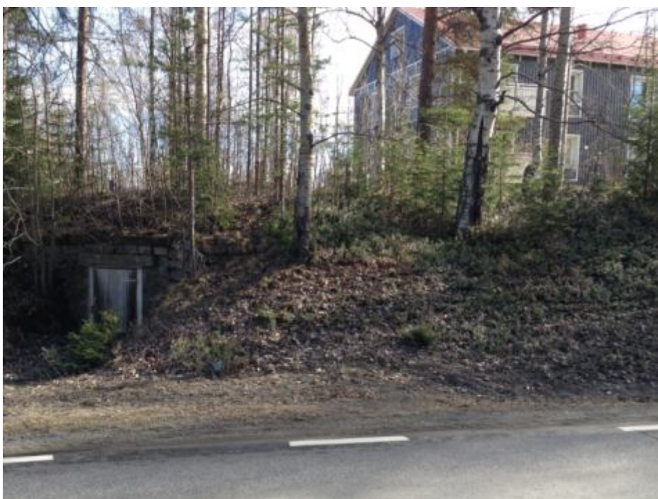
Bild 14; Visar trång sektion vid Lugnet, där den naturliga slänten kommer att påverkas
