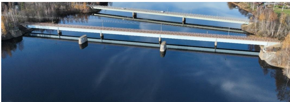
Figur 9. Bild på befintlig vägbro och järnvägsbro samt de gamla brostöden. Bild tagen mot norr.
