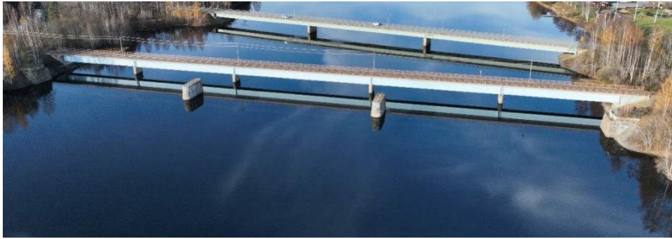
Figur 13. Bild på befintlig vägbro och järnvägsbro samt de gamla brostöden. Bild tagen mot norr.
