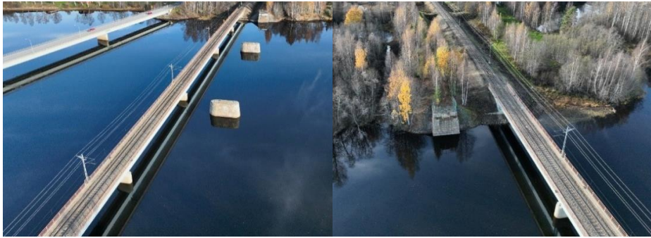
Figur 6. (Till vänster) Bild på befintlig vägbro till vänster, järnvägsbron i mitten samt befintliga brostöd till höger. Bild är tagen mot öst. (Till höger) Bild på järnvägen och det befintliga västra landfästet. Bild är tagen mot väst.
