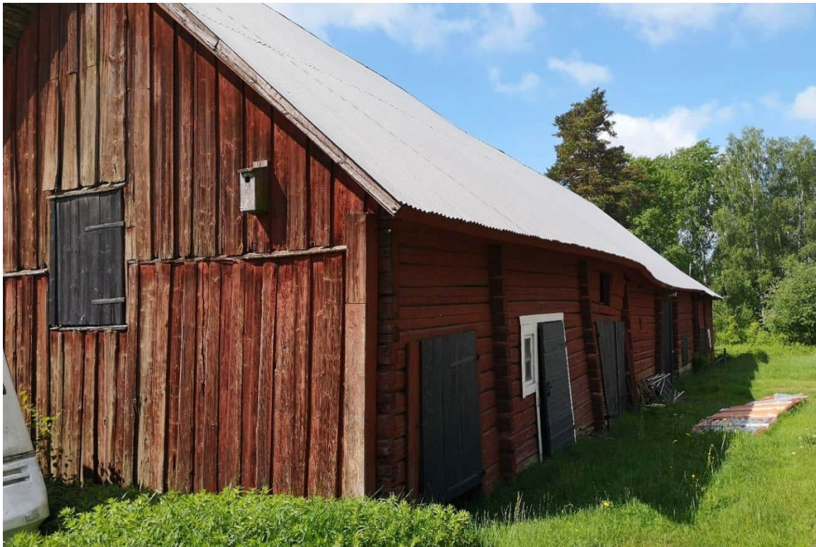
Figur 12. Ekonomibyggnad vid "Näbben".
