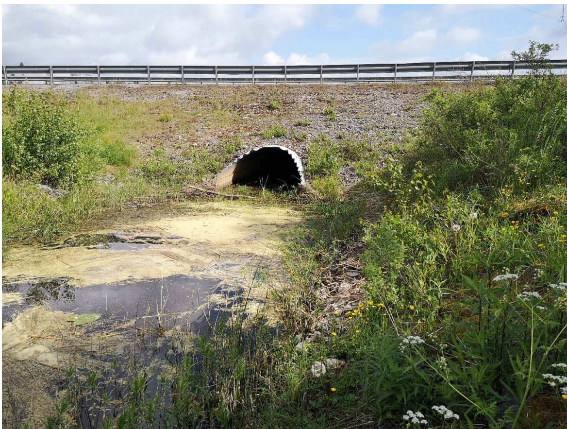
Figur 20. Trumma under väg 61 som förbinder Klacksjön och Åstjärnet.
