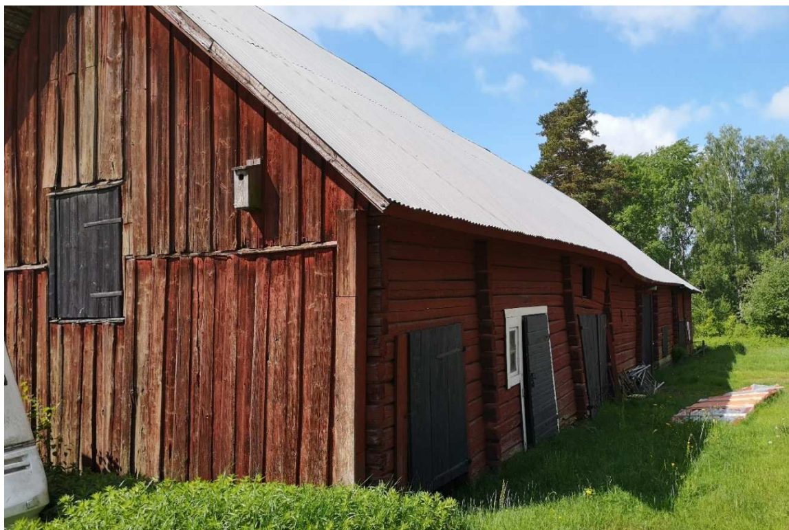
Figur 12. Ekonomibyggnad vid "Näbben".
