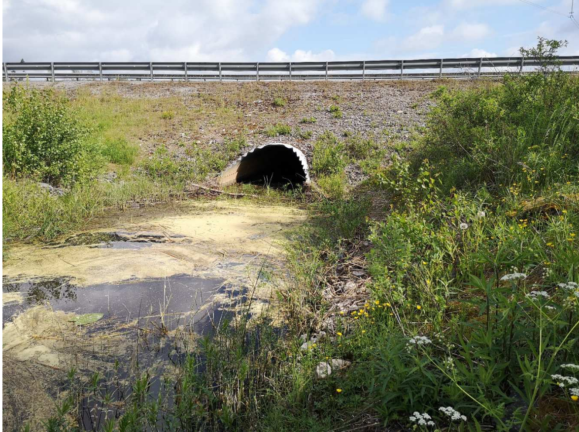
Figur 16. Trumma under väg 61 som förbinder Klacksjön och Åstjärnet.
