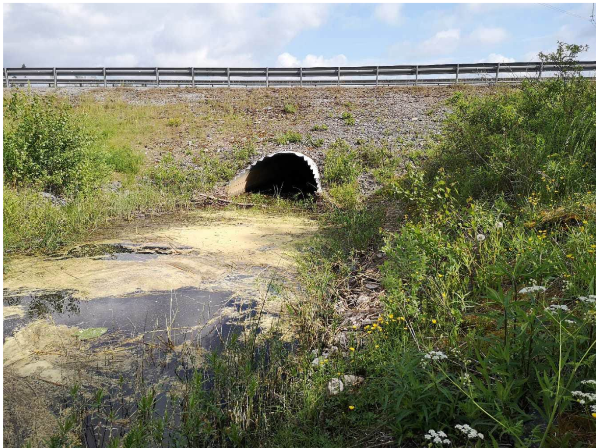
Figur 23. Trumma under väg 61 som förbinder Klacksjön och Åstjärnet.
