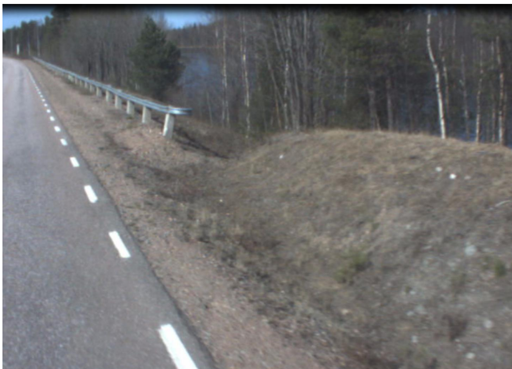
Figur 2. Foto med vy från väg 395 norrut i södra delen av sträckan för planerat erosionsskydd
