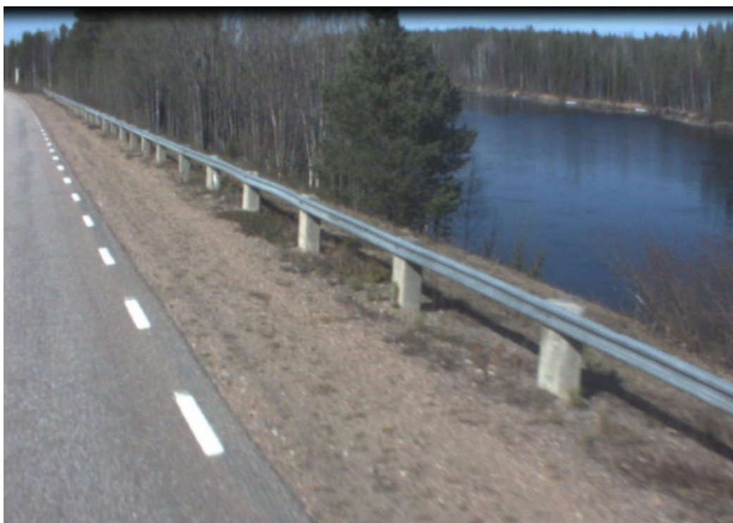
Figur 3. Foto där väg 395 går närmast älven och erosionsskyddet kommer att anläggas
