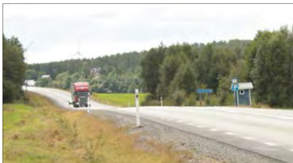
Figur 38. Busshållplats Vallen - södergående. Hållplats på parkeringsficka.
