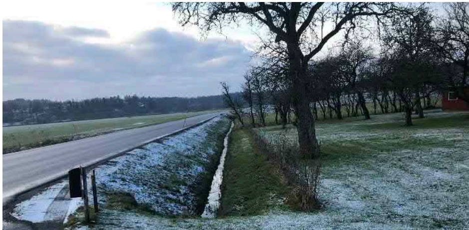
Figur 10. Vägsträckans befintliga utseende förbi fastigheten Vallby 1:4.
