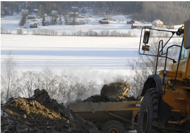
Ett tiotal dumprar användes vid schaktarbeten på väg 45 vilket medförde en besparing på ca tre miljoner kronor. Foto: Marie Lundqvist
