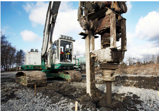
För att i första hand begränsa sättningar har omfattande förstärkningsåtgärder utförts, främst bestående av kalkcementpelare, lättfyllning och bankpållning, till en total geoteknisk kostnad som överstiger en miljard. Foto: Kasper Dudzik
