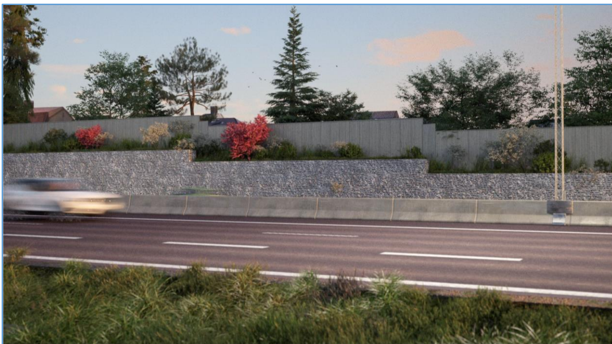
Figur 41. Illustration som visar hur bulleråtgärderna med skärm och gabionmur utmed villaområdet Backen/Ljungarum dämpas via planteringar.
