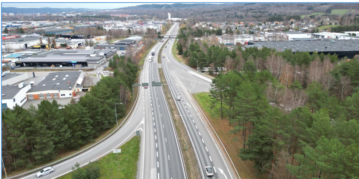
Figur 3. E4/väg 40, delen mellan trafikplats Ljungarum och trafikplats Ryhov.
