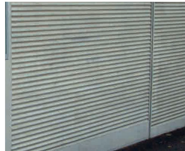
Figur 22. Exempel på betongyta med sinusmatrismönstrad yta
