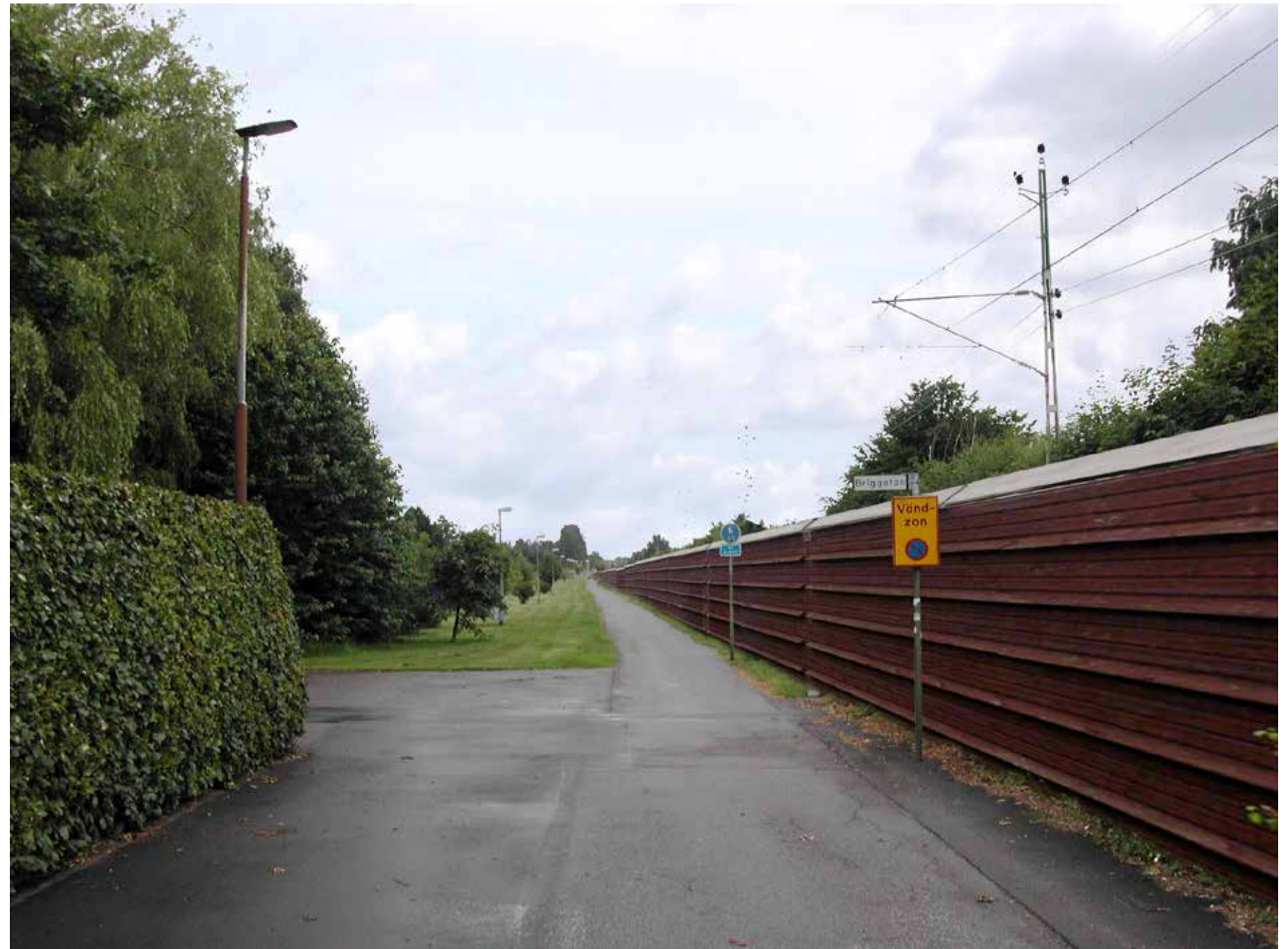
► Figur 3-21. Fotomontage. Exempel på bullerskyddsskärm söder om Karstorpssvägen i Lomma. Omfattning och utformning av bullerskydd kan variera beroende på utredningsalternativ.
