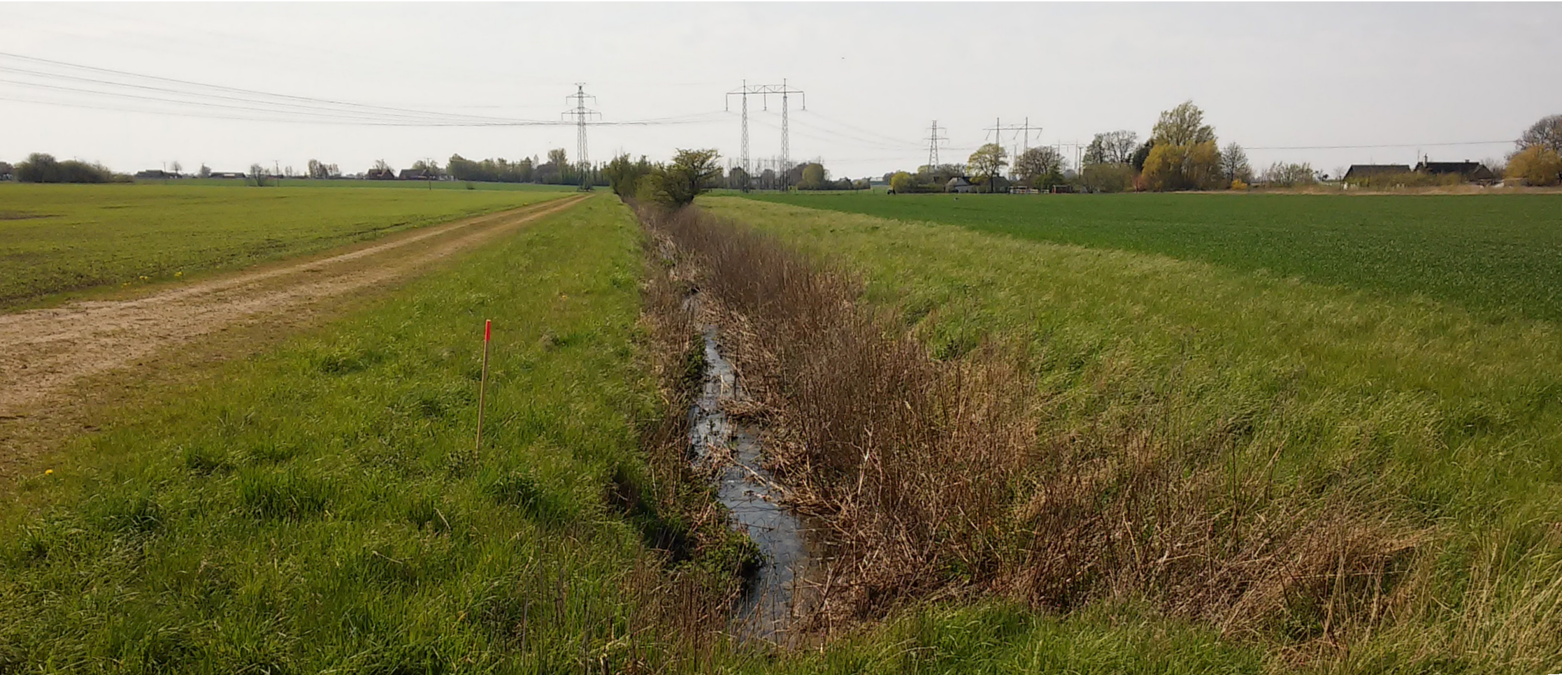
Befintligt öppet dike i Stävie, väster om järnvägen.
