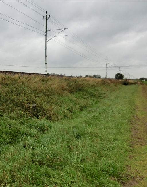
Befintlig järnväg på bank, foto taget i riktning söderut
