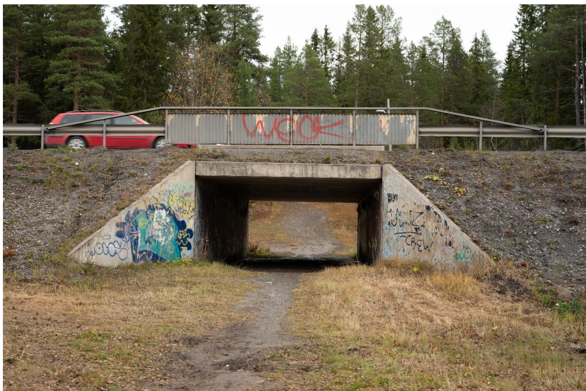
Figur 13 – En vanlig förekommande typ av bro över gångväg, väg E14/E45, bro nr 23-833-1.
