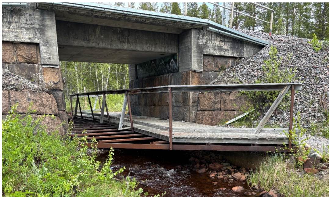
Figur 13 Fotografi av passage under järnvägen.
