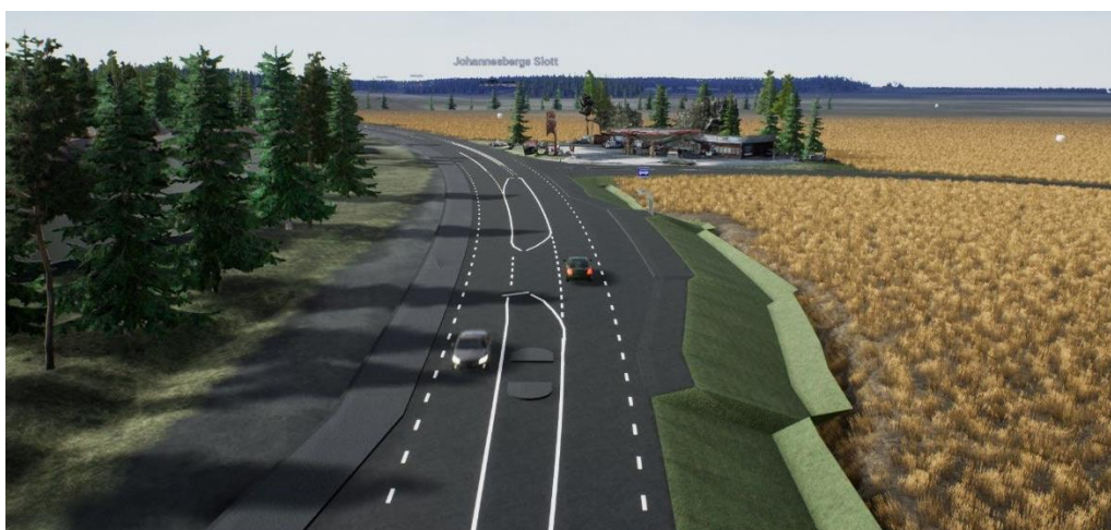
Figur 33. Vy vid Götröra med bussficka och ombyggnad vid befintlig bensinstation/servicepunkt.
