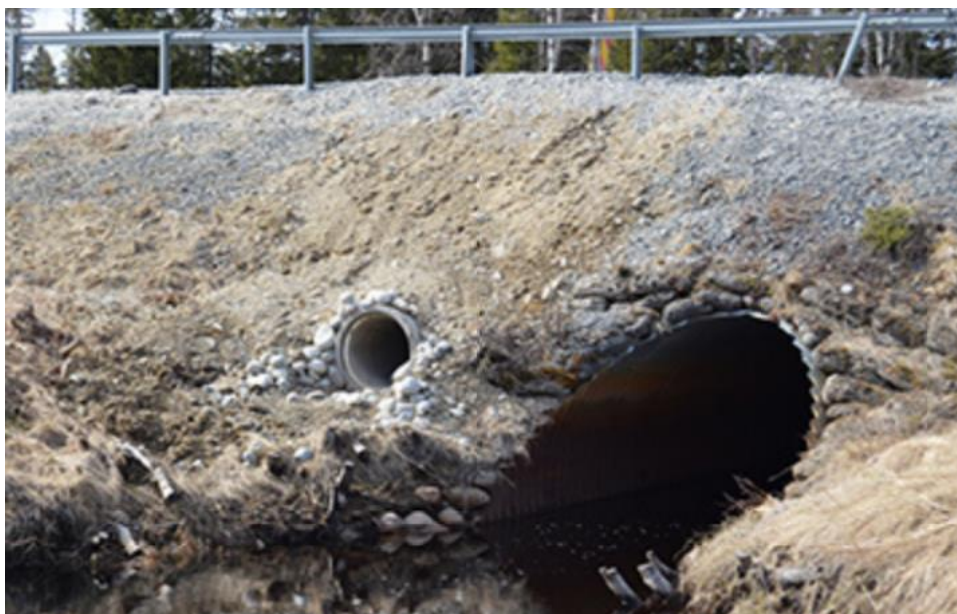
Figur 40. Exempel på torrtrumma vid vattendrag. Foto Trafikverket.
