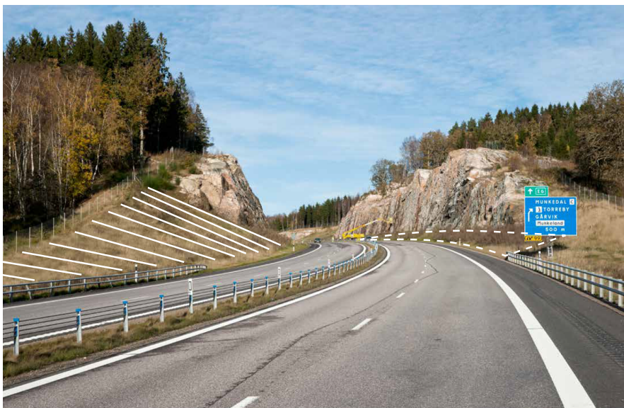
Figur 25. Till vänster i bild sker övergången mellan berg-och jordskärning på ett mjukare och naturligare sätt med propellerbladsutformning av slänten. Höger i bild visar på hur skärningar ska utföras med vegetationsklädd förgård mellan väggkant och skärning (Trafikverket 2015). Illustrationstillägget i bilden gjordes av AF Infrastructure.
