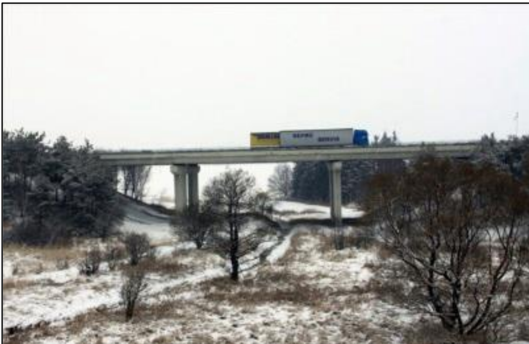
Figur 11.2 Exempel på viltpassage i form av en landskapsbro.
