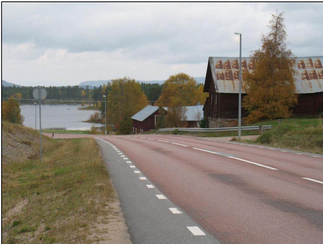
Figur 11.8 Bebyggelselämning (byggnaden närmst till höger om vägen) nära befintlig väg genom Byvallen.
