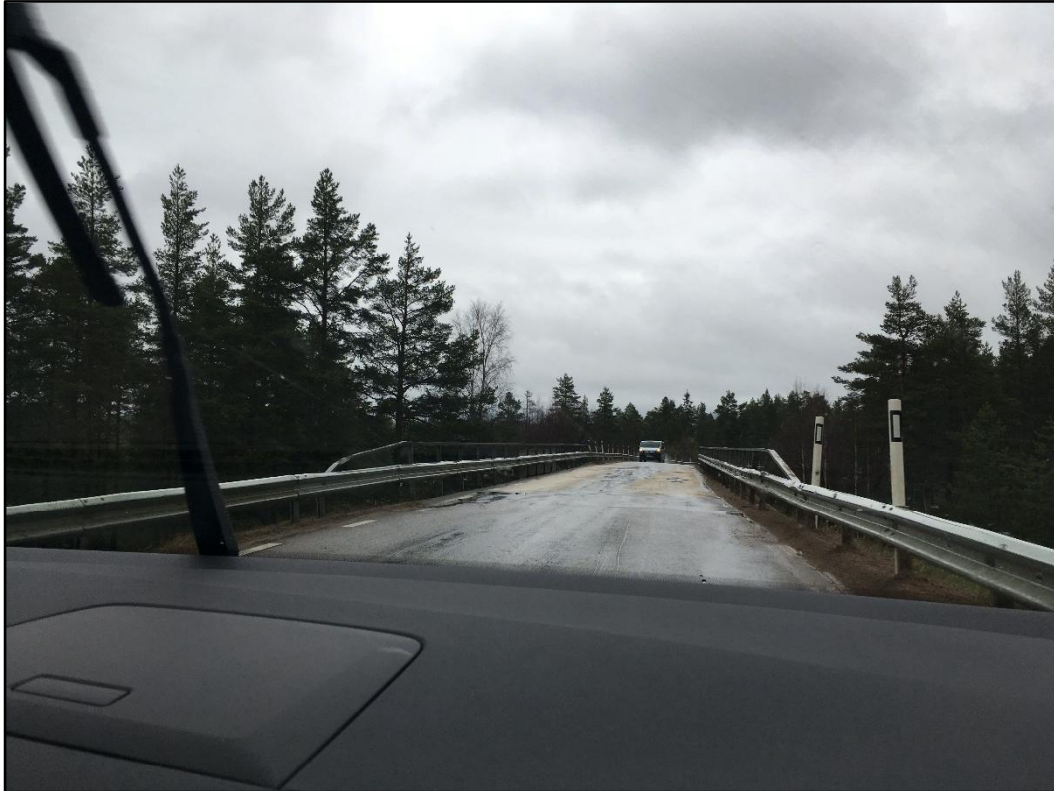
Figur 2.5 Bron över järnvägen sydost om Sveg.
