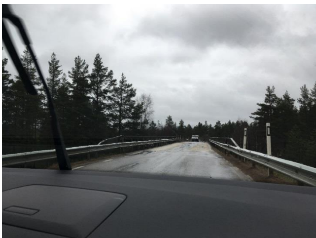
Figur 2.5 Bron över järnvägen sydost om Sveg.
