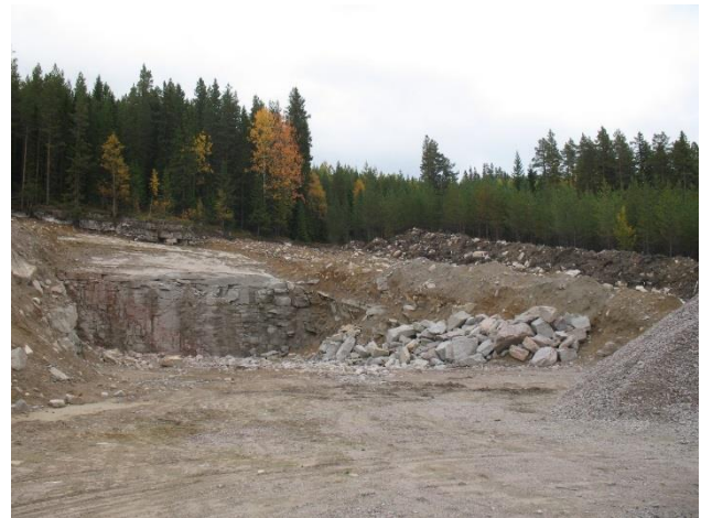
Figur 10.35. Husbehovstäkt på sydvästra sidan av Nonsberget (september 2017).
